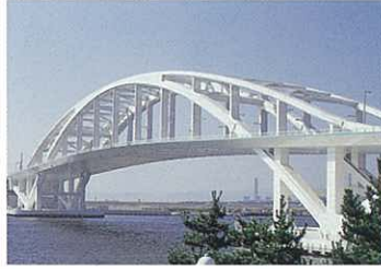
第3回 夢舞大橋 〈大阪市此花区/新築・橋梁〉
