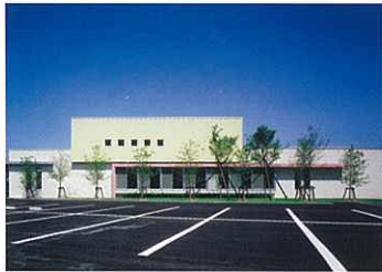
第10回 柏崎厚生病院新外来棟 〈新潟県柏崎市/新築・公共施設〉
